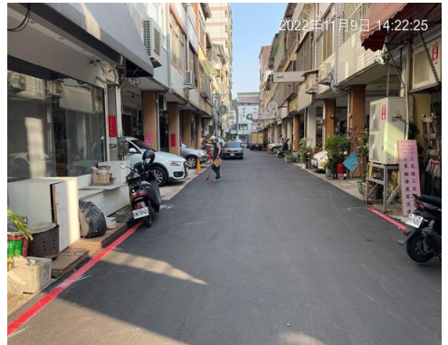
小型工程施工。
